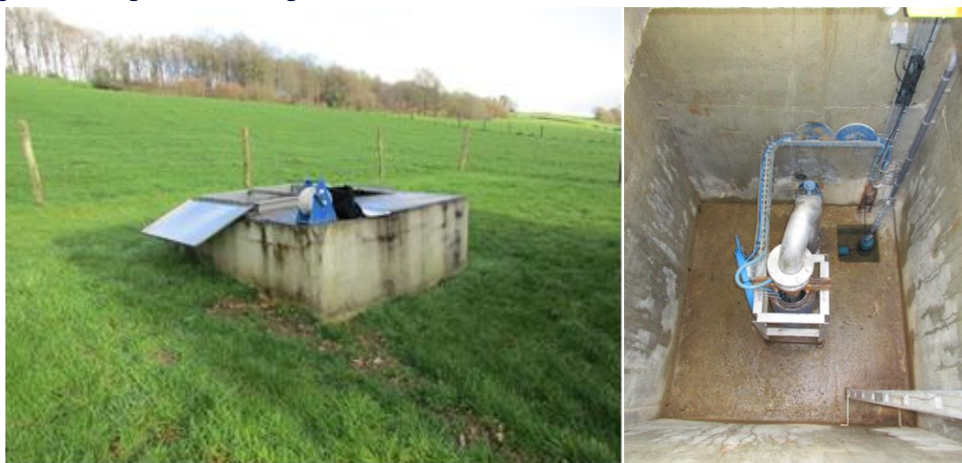
Figure 2 : Forage du Fond Cugnet
